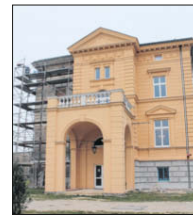
Derzeit wird die Fassade am Gutshaus erneuert.
